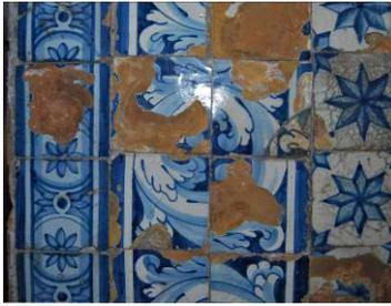
Figura 3a- Perda de vidrado ao centro e arestas, sem danos na chacota. Capela de Nossa Senhora dos Remédios, Peniche. Data da inspeção: Julho 2013
